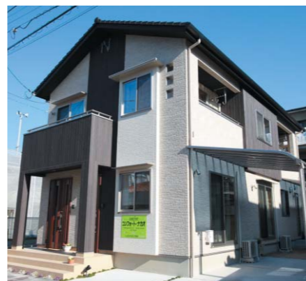
空気循環と高気密・高断熱施工で、季節を問わず室内を快適に保つと同時に、住まいの耐久性も高める
