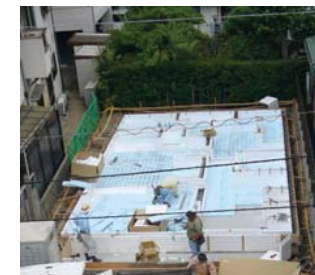
基礎工事中です。
