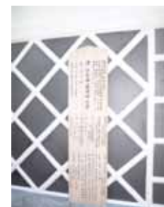
棟板には工事の内容と携わった人の名前が書いてあります。
