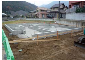
只今基礎工事が完了したところです。
