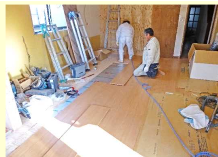
フローリング施工中
