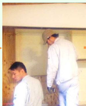
キッチン取付中
