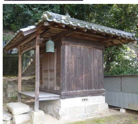
中埜坊観音堂 焼き杉を使って外装を全て張り替えました。
