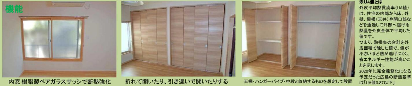
内窓 樹脂製ペアガラスサッシで断熱強化
