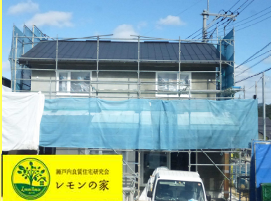
外壁・そん壁下塗り完了
