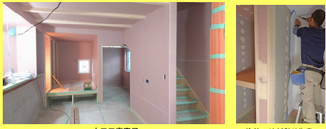
大工工事完了
