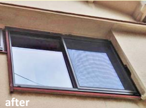
↑昔ながらの木枠のガラス戸は窓枠とガラスを取外し、新たな窓枠を付け、複層ガラスに交換しましたこれで冬は暖かくなります
