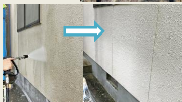
コケなど汚れがひどい箇所は、専用の高圧洗浄機できれいにしてから、塗装工程にかかります
