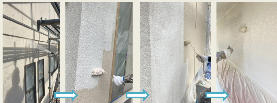
水洗い→下塗り(白)→本塗り(1回目)→本塗り(2回目) 全工程、乾いてから進めます(ラジカル塗料)
